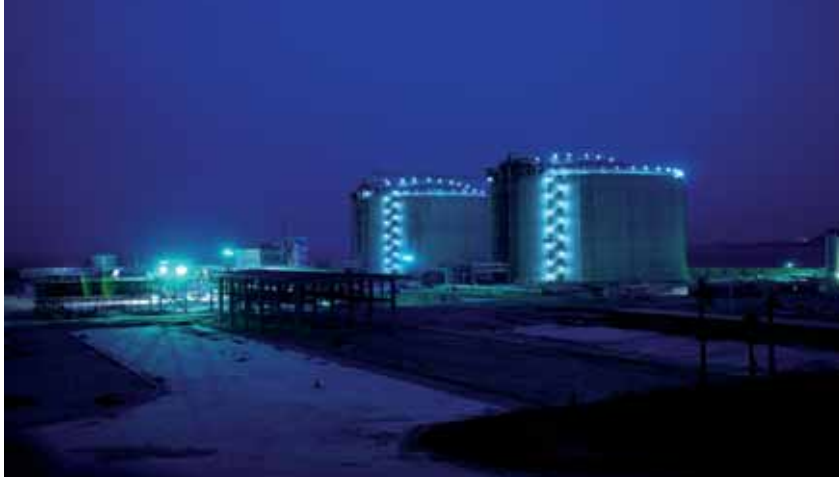
Fujian LNG, China - 2006
