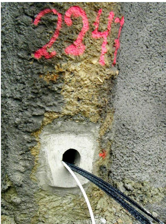
Vorstehendes Auflager mit Mörtelbett, noch ohne Grund- und Ankerplatte
