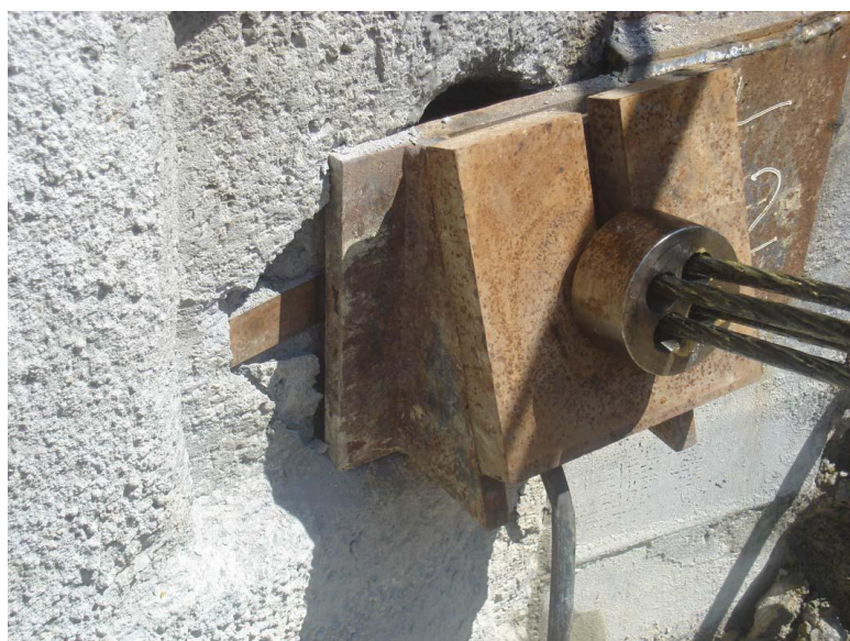
Auflagerkonstruktion mit Grundplatte, Stahlkeilen und Ankerplatte
