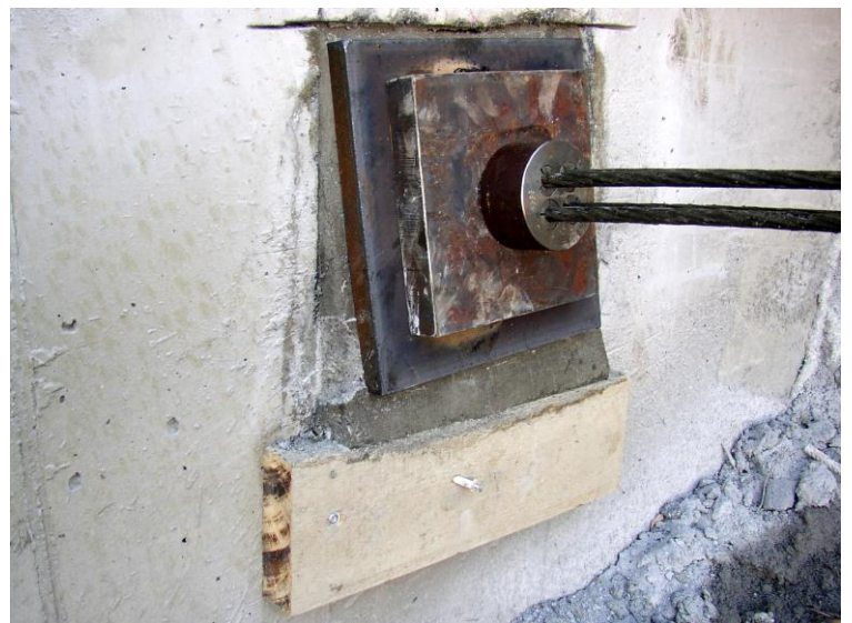
Anker mit Mörtelbett, Grundplatte und VSL Ankerplatte
