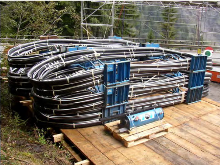
Corbeilles superposées sur chantier, sur un espace propre et plat
