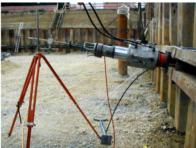
Processus de mise en tension avec mesure de l'allongement
