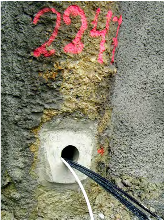
Support en saillie avec lit de mortier, avant pose des plaques de base et d'appui
