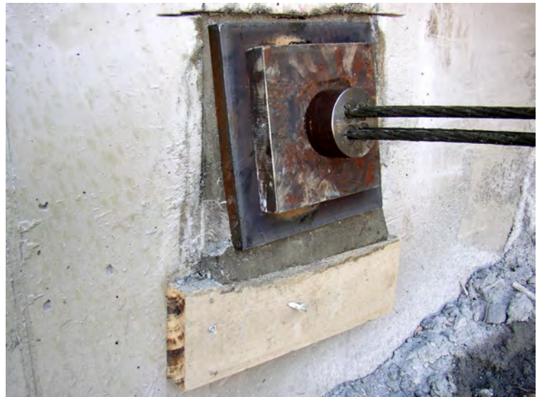
Tirant avec lit de mortier, plaque de base et plaque d'appui VSL
