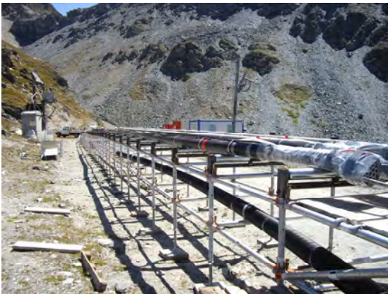
Fabrication sur chantier....
