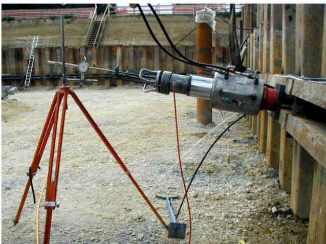
Spannvorgang mit Dehnwegmessung
