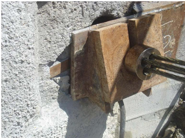
Auflagerkonstruktion mit Grundplatte, Stahlkeilen und Ankerplatte
